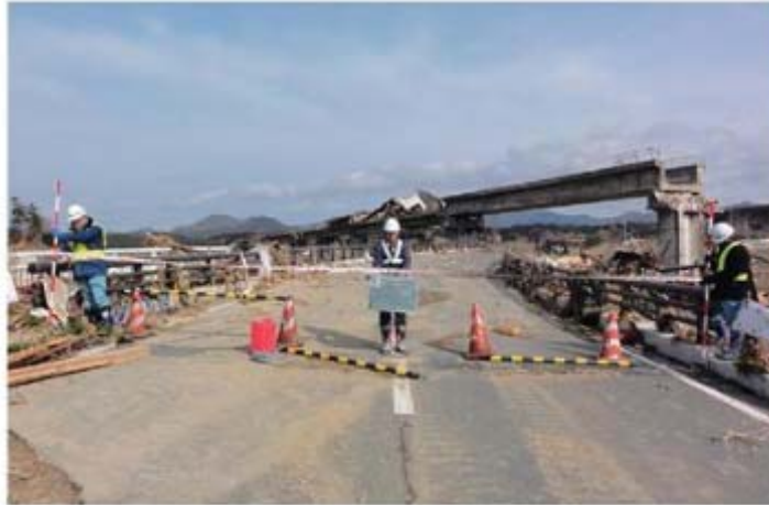
小泉大橋起点側土工部
