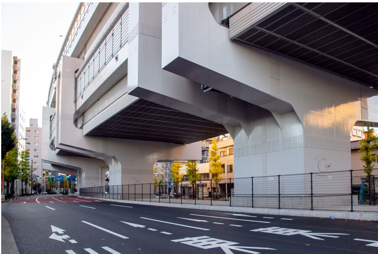
■中央環状線板橋・熊野町ジャンクション間 拡幅高架橋／所在地：東京都板橋区
