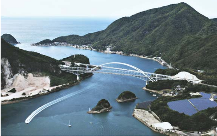
熊本県上天草市と宇城市を結ぶ自動車専用橋・天城橋(てんじょうきょう)。橋長463mの鋼PC複合中落式アーチ橋だ。鋼箱製のアーチリブを支間長350m(ソリッドリブ方式では国内最長)で両端をリブ固定支持し、補剛桁は中央径間を鋼箱桁、側径間をPC箱桁で構成している。設計は大日本コンサルタントで、管理技術者は新井社長。1966年完成の天草5橋の1号橋・天門橋に並んで架けられることから、「周辺に調和しながらも40数年の技術的進展が感じられる橋」をコンセプトとした。(写真は同社提供)
