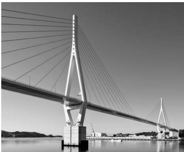
東日本大震災からの復興の1つとして、3月に開通した全長1344mの気仙沼湾横断橋。斜張橋の設計を担当した大日本コンサルタンが、想定を超える強い構造に耐えるための設計を行った。同社提供
